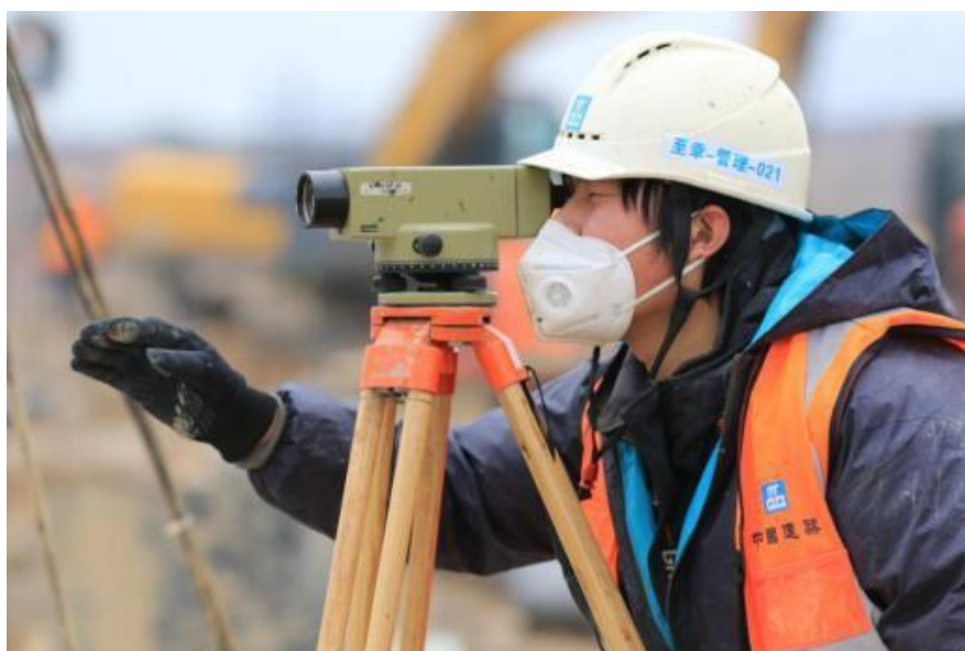
图 2-7 1702 天衡班陈志杰在火神山医院施工工地进行测量
