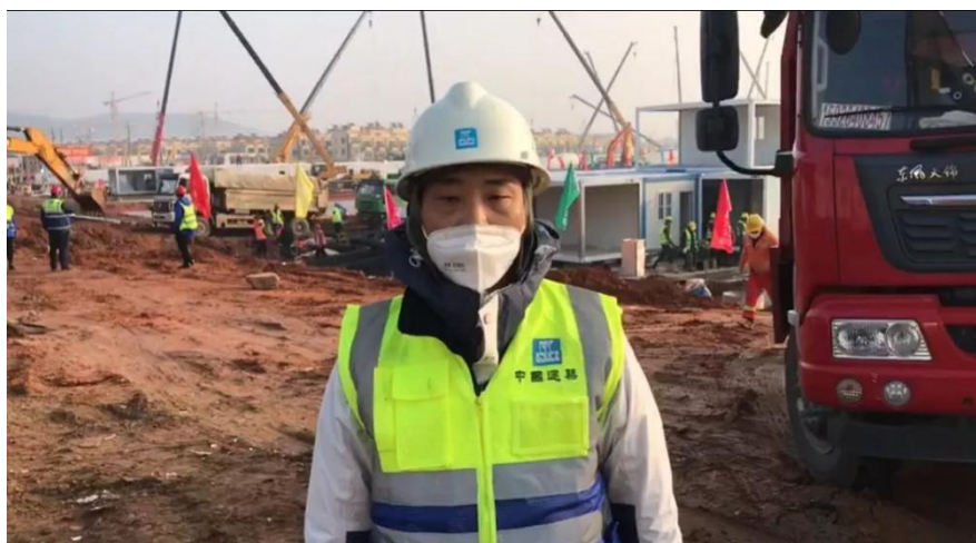
图 2-6 工民建 0002 班鲁波在火神山医院施工现场
